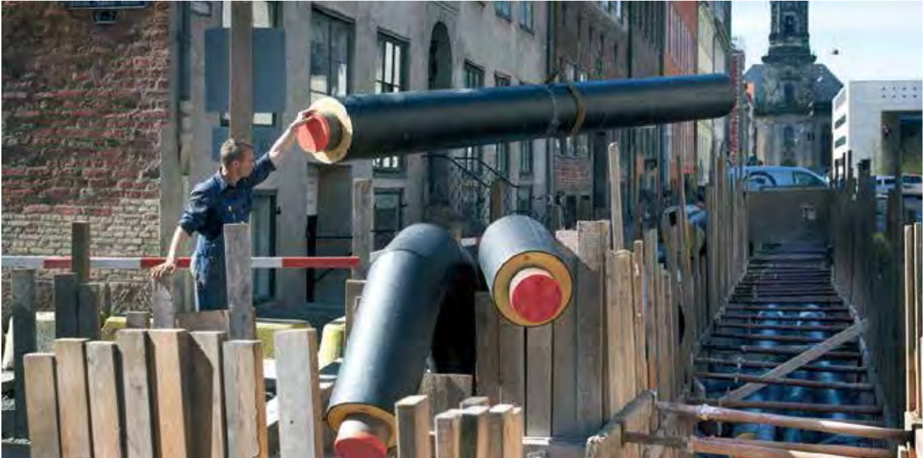
Abb. 10: Installation neuer DH-Rohre in Kopenhagen
