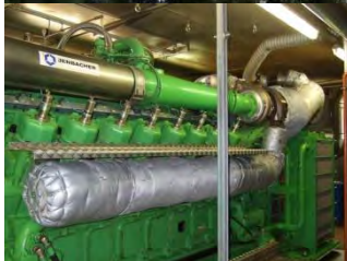
Gasmotor 2 MW el
