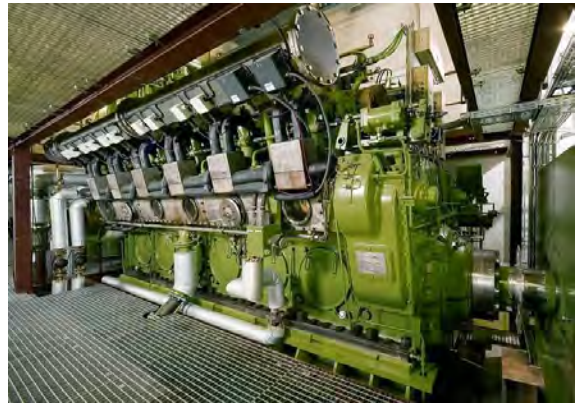
Biomethanmotor 5 MW el
