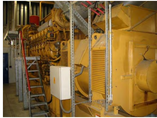
Gasmotoren 2 x 2,9 MW el
