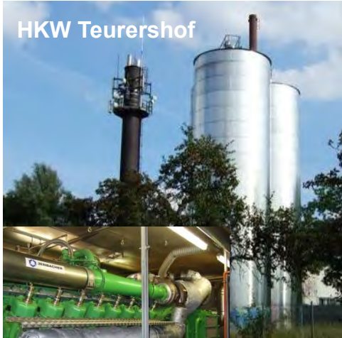
Gasmotor 2 MW el
